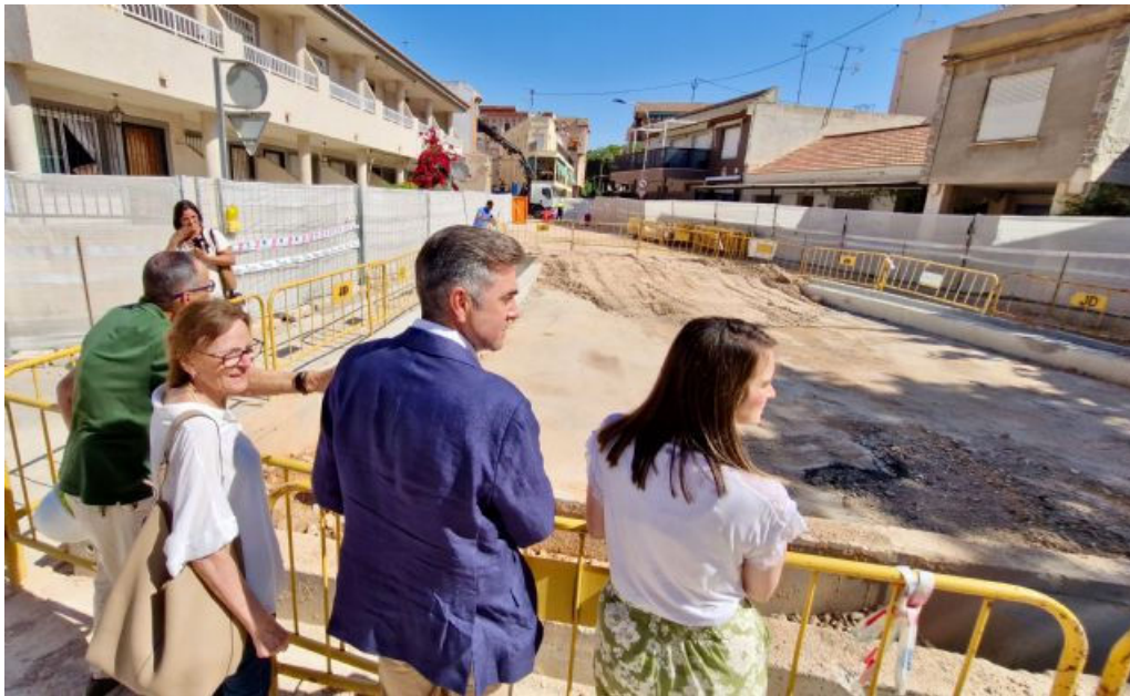
Francisca Baraza visita la ampliación de la capacidad del colector de la EDAR - 5, Foto 5
