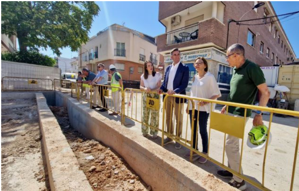
Francisca Baraza visita la ampliación de la capacidad del colector de la EDAR - 2, Foto 2
