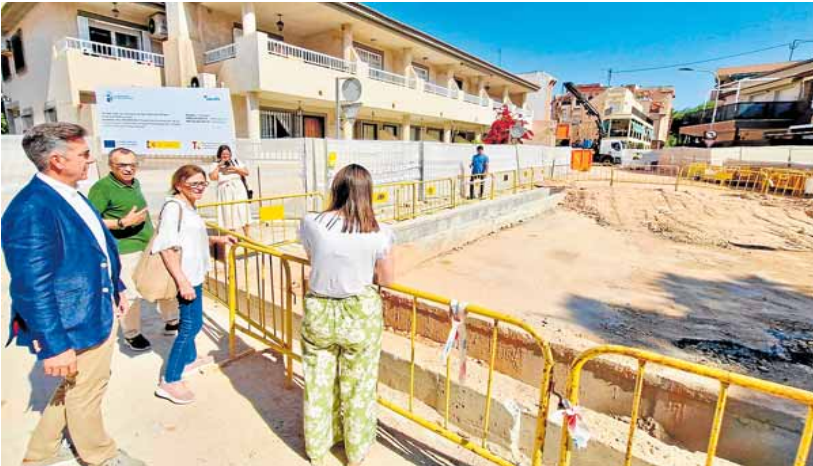
Pedro Javier Sánchez y Francisca Baraza, ayer, durante la visita a las obras. MITECO
