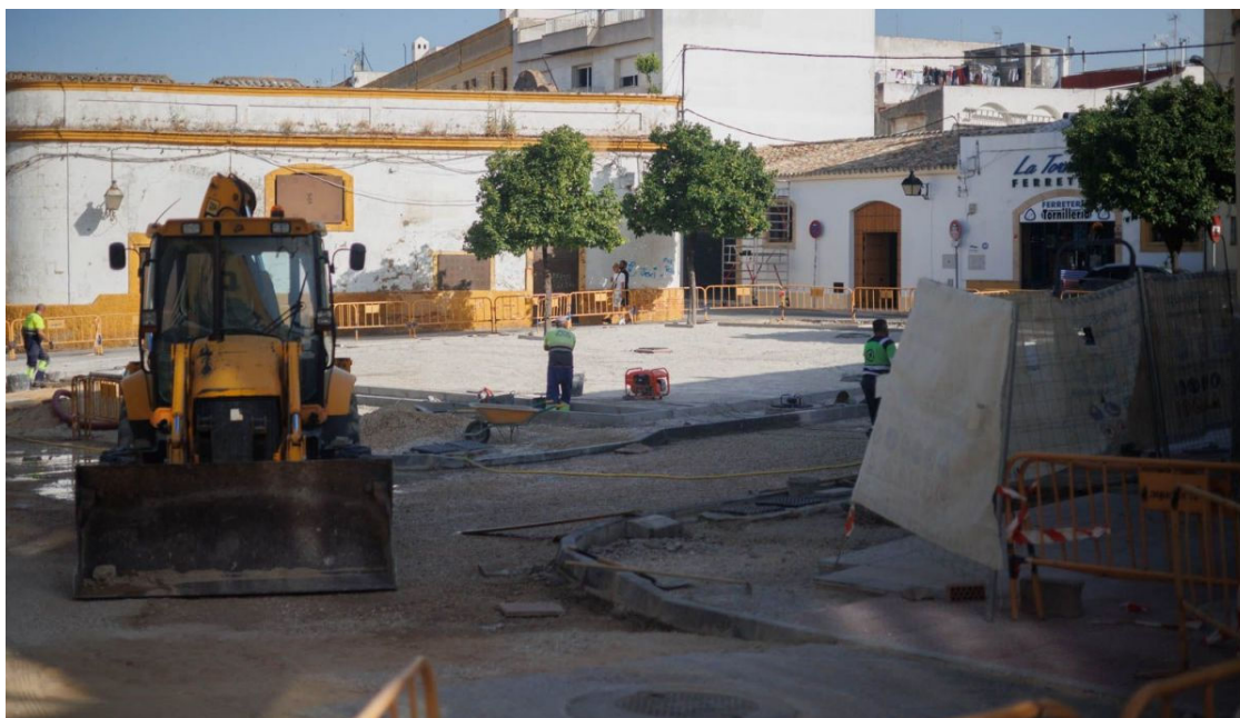
Estado actual de las obras de Plaza del Carbón, este miércoles. MANU GARCÍA
