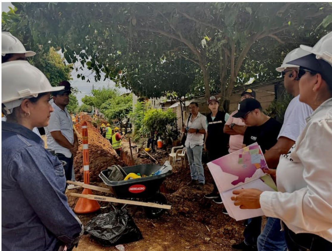
Aqualia y Alcaldía de Santa Cruz de Lorica hacen seguimiento técnico a las obras de optimización hidráulica del norte.
